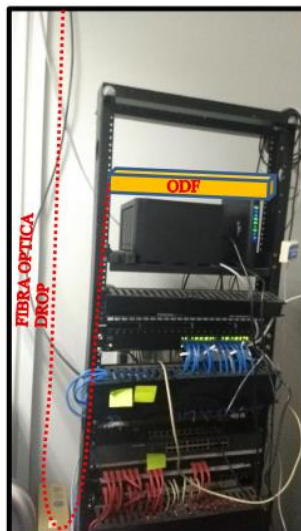
Foto 9. Cable de fibra óptica descendiendo de falso techo con canaleta proyectada y llega a rack del cliente, donde terminara en una bandeja con ODF.
