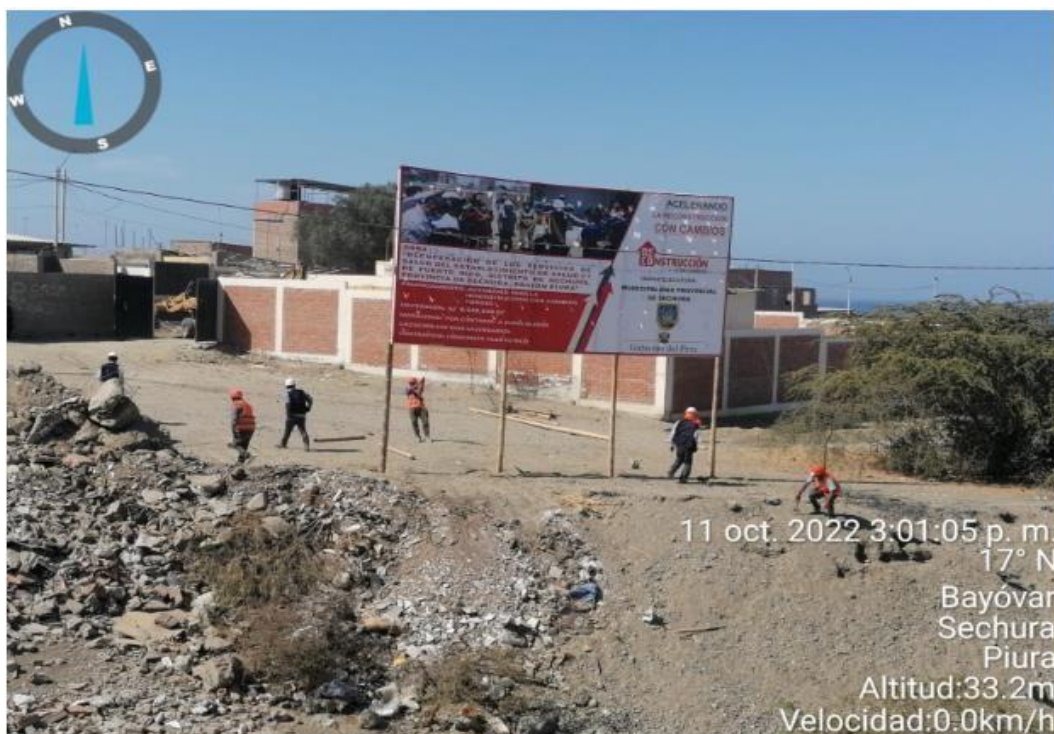
Figura 2: Obra en ejecución en la Región Piura
