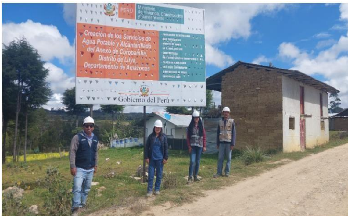
Figura 1: Obra en ejecución en la Región Amazonas
