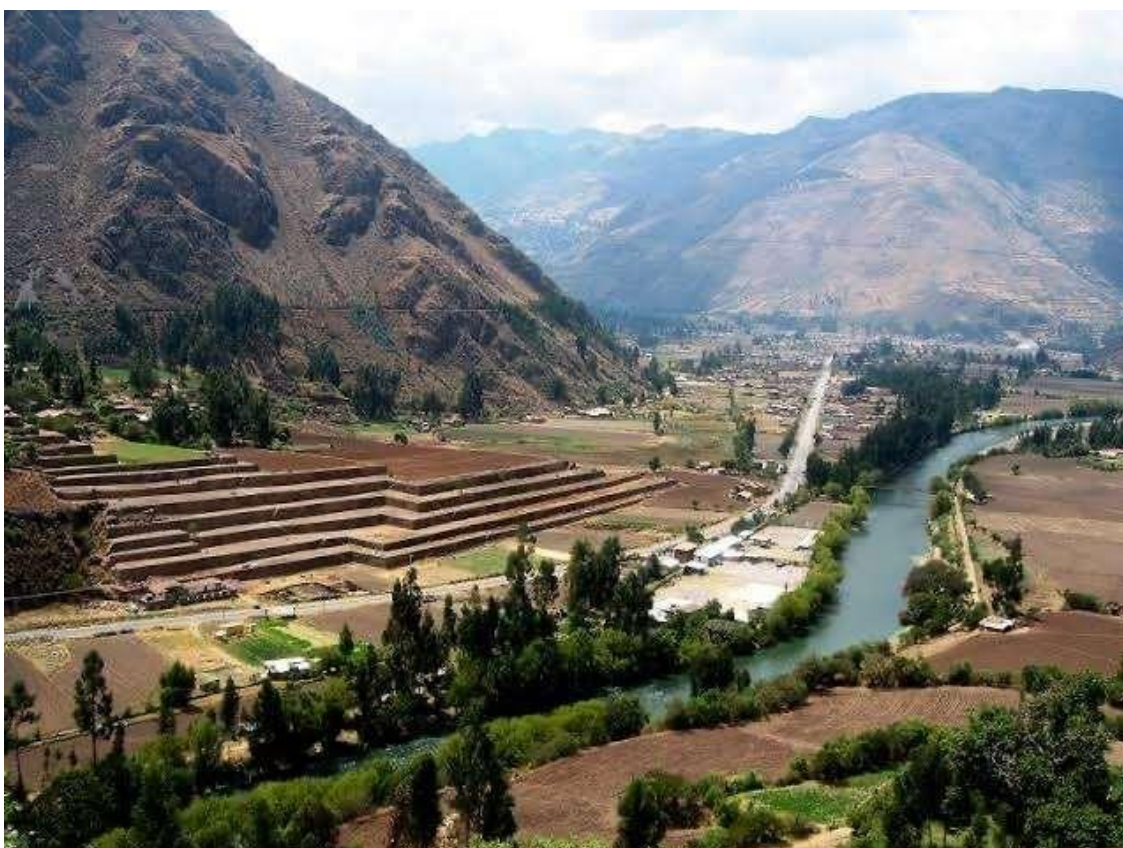
Imagen 11 Vista Panorámica de terrazas.
