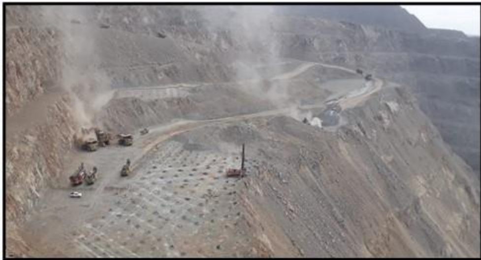
Figura 6 Proceso de Perforación - Perforadora Sanvik D75KS
