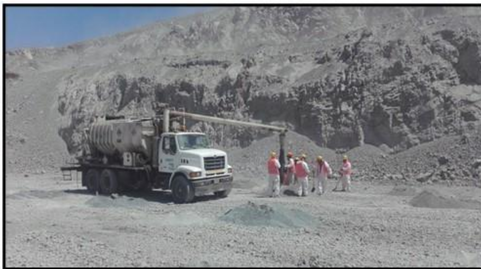
Figura 7 Proceso de Voladura – Camión fabrica cargando Anfo.
