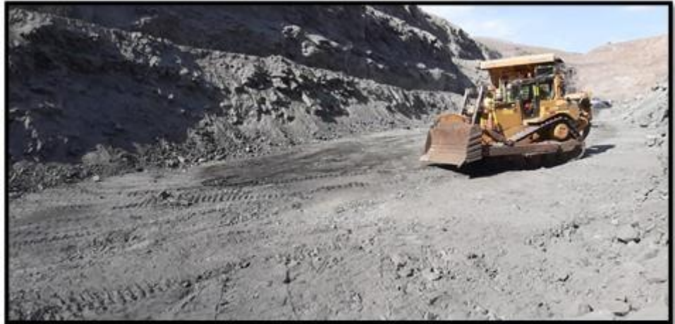
Figura 25 Corte de Vía – Tractor D9T
