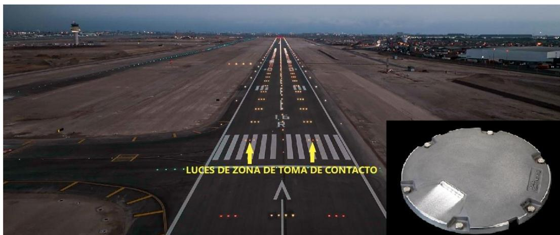
Figura 4.75: Equipo y Luces de Zona de Toma de Contacto instalación del AIJCH. (Fuente: E. Propia)
