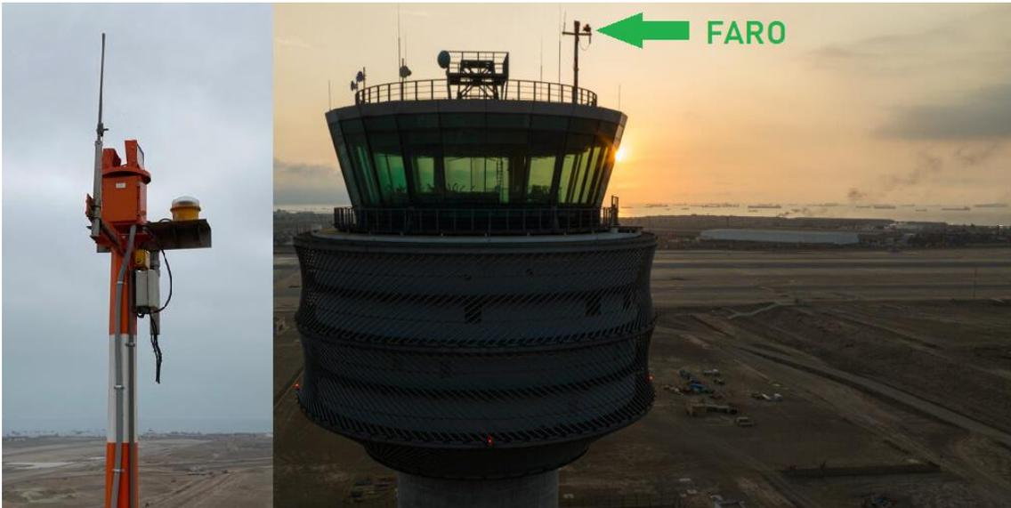
Figura 4.81: Vista de ubicación de Faro en la Torre de Control. (Fuente: E. Propia)
