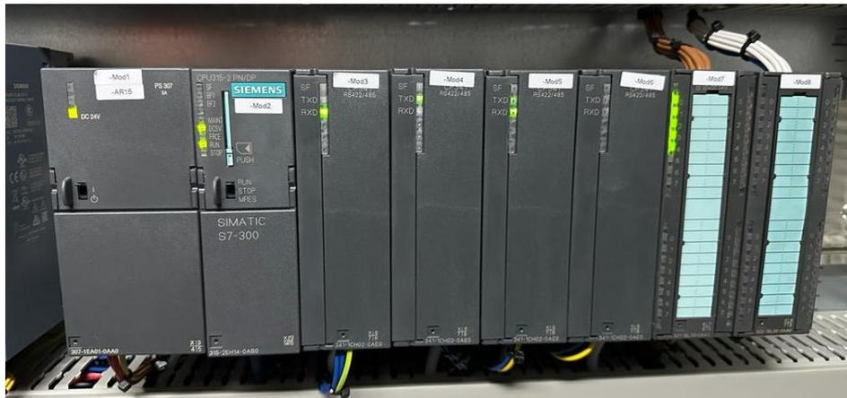
*Figura 4.51: PLC Siemens S7-300 CPU 315-2. (Fuente: E. Propia)*
