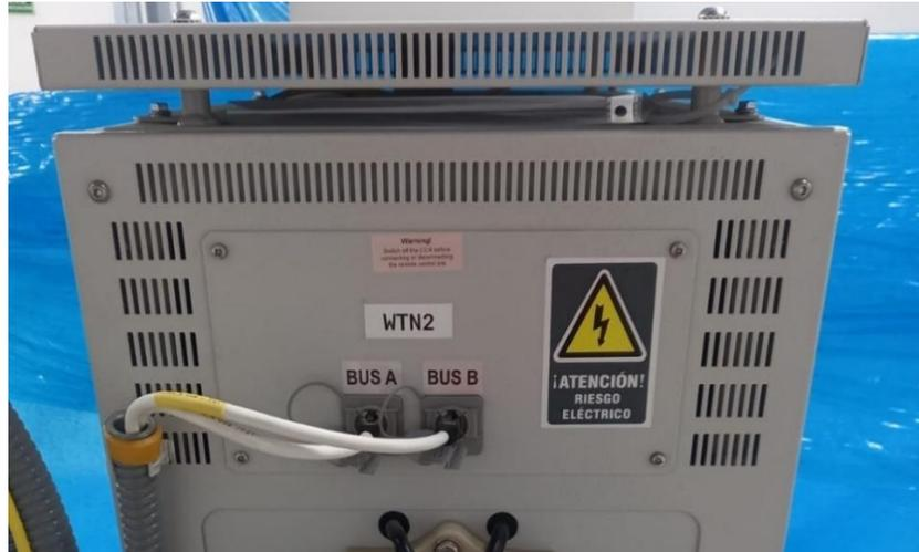
Figura 4.63: Conexión de Cables Ethernet en Reguladores CCR (Fuente: E. Propia)
