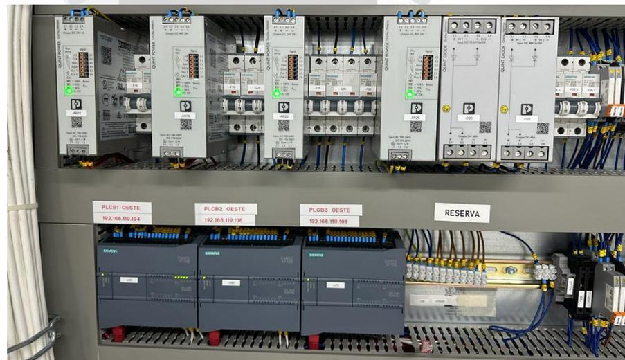
Figura 4.49: PLC Siemens S7-1200 en gabinetes de Sala Oeste. (Fuente: E. Propia)
