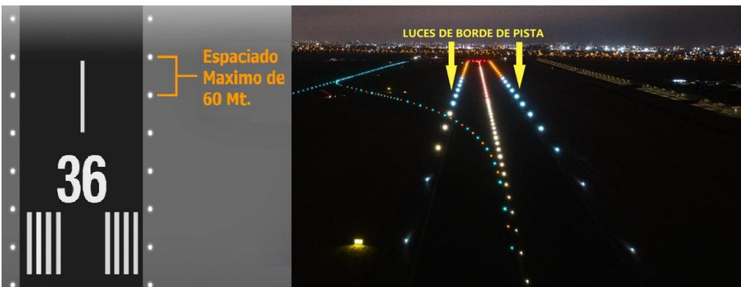
Figura 4.73: Luces de Borde Pista en la instalación del AIJCH. (Fuente: E. Propia)
