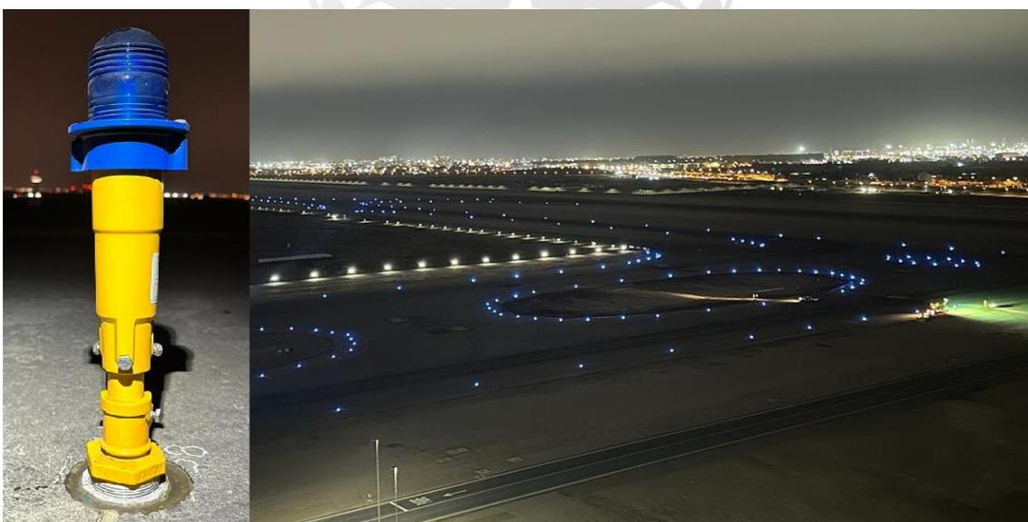
Figura 4.77: Equipo y Luces de Borde de Calle de Rodaje instalados en el AIJCH. (Fuente: E. Propia)
