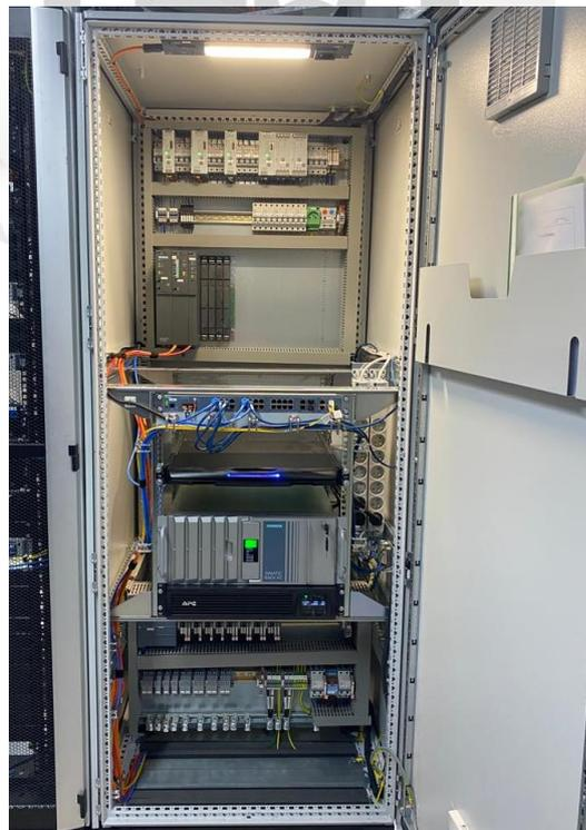
Figura 4.48: Servidor Siemens SIMATIC IPC547J y PLC Master S7-400H instalado en Gabinete ATC.
