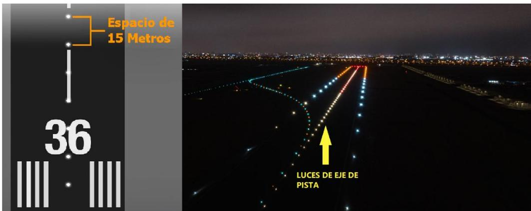
Figura 4.72: Luces de Eje de Pista en la instalación del AIJCH. (Fuente: E. Propia)
