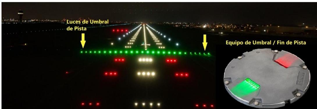
Figura 4.74: Equipo y Luces de Umbral / Fin de Pista en la instalación del AIJCH. (Fuente: E. Propia)
