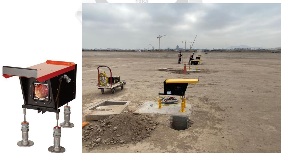
Figura 4.71: Vista del Equipo PAPI y la instalación de las Luces PAPI. (Fuente: E. Propia)
