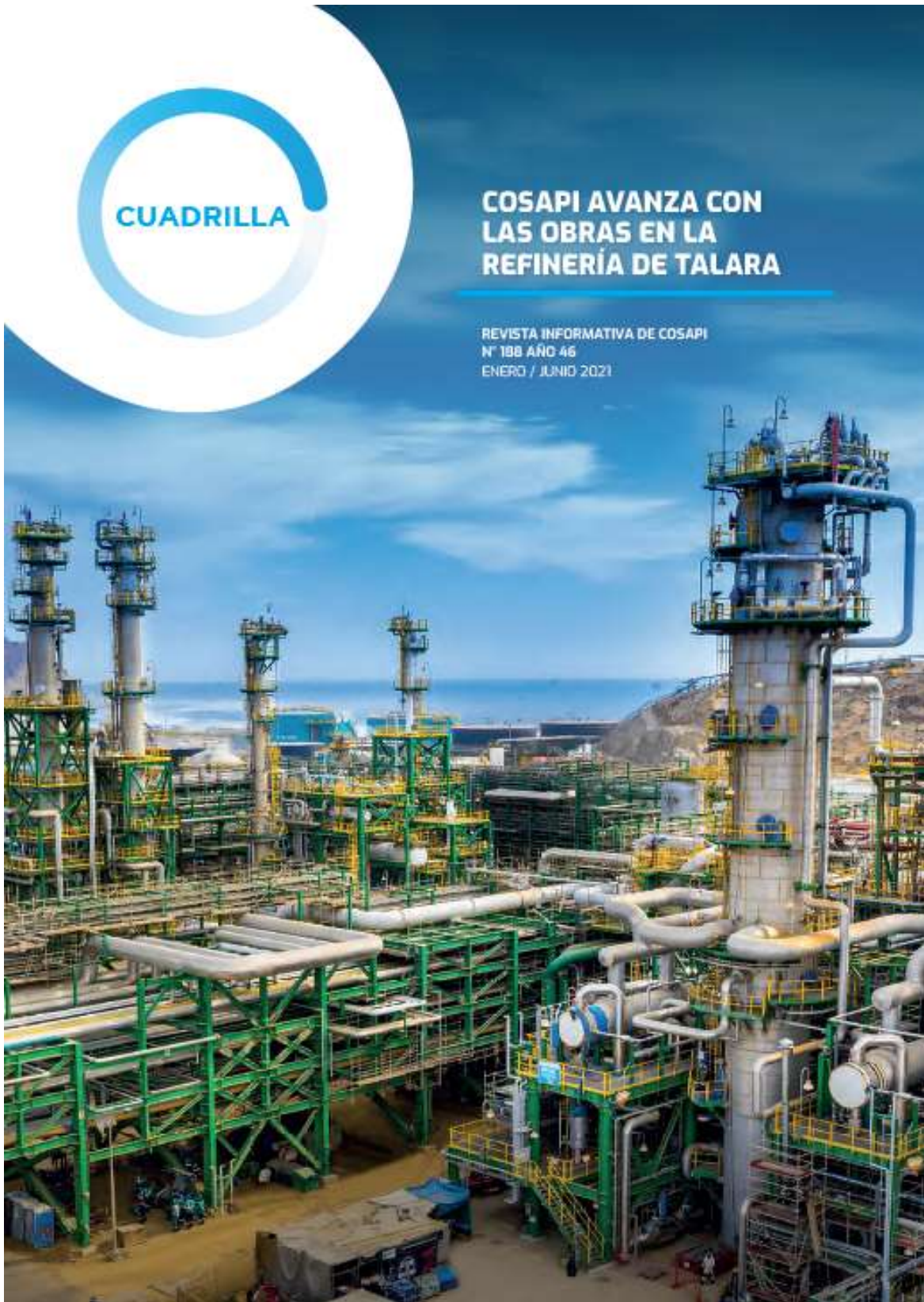
Figura N° 08 - Proyecto de Modernización de la Refinería de Talara
