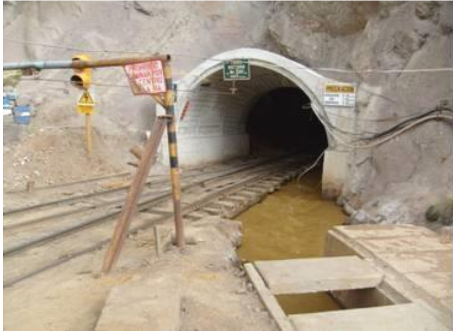
Foto N° 1. Boca Túnel-Mina Carahuacra-salida de agua ácida.
