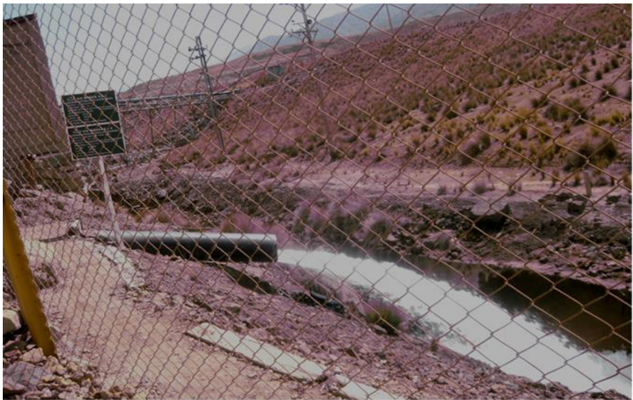
Foto N°3. Rio Yauli, efluente de las operaciones planta de neutralización
