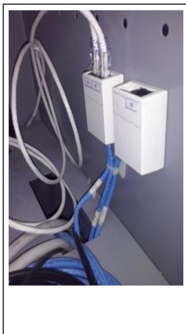
**3.3 Conectar Patch cord en cpu.-** Se deja conectado un patch cord entre el cable Data1 y el puerto de red de la cpu, se conecta otro patch cord entre el cable Data2 y puerto de red de video
