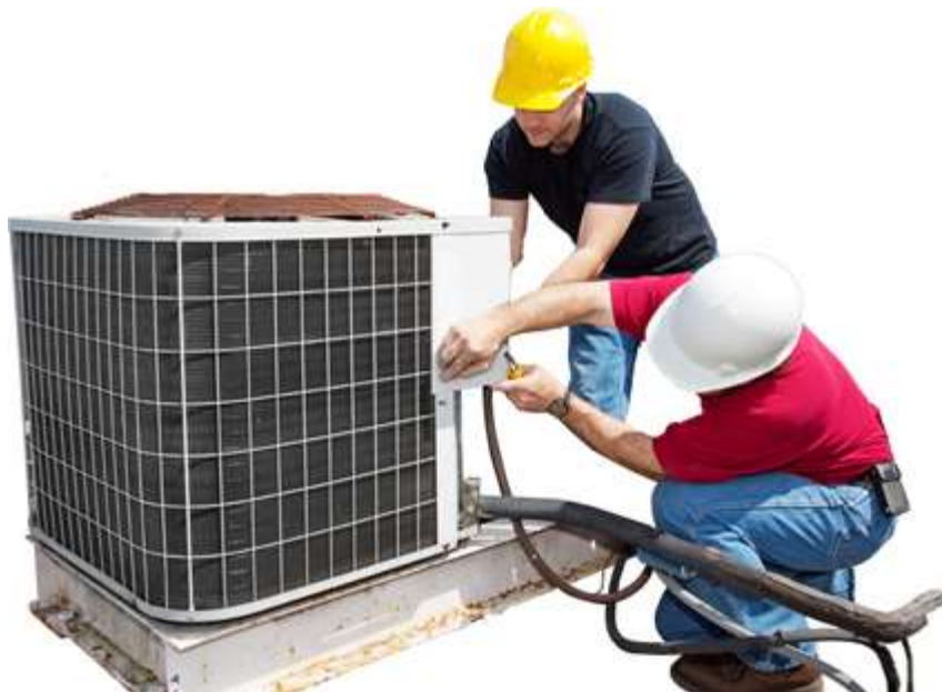
Fig. 18. Servicio de mantenimiento preventivo y correctivo.
