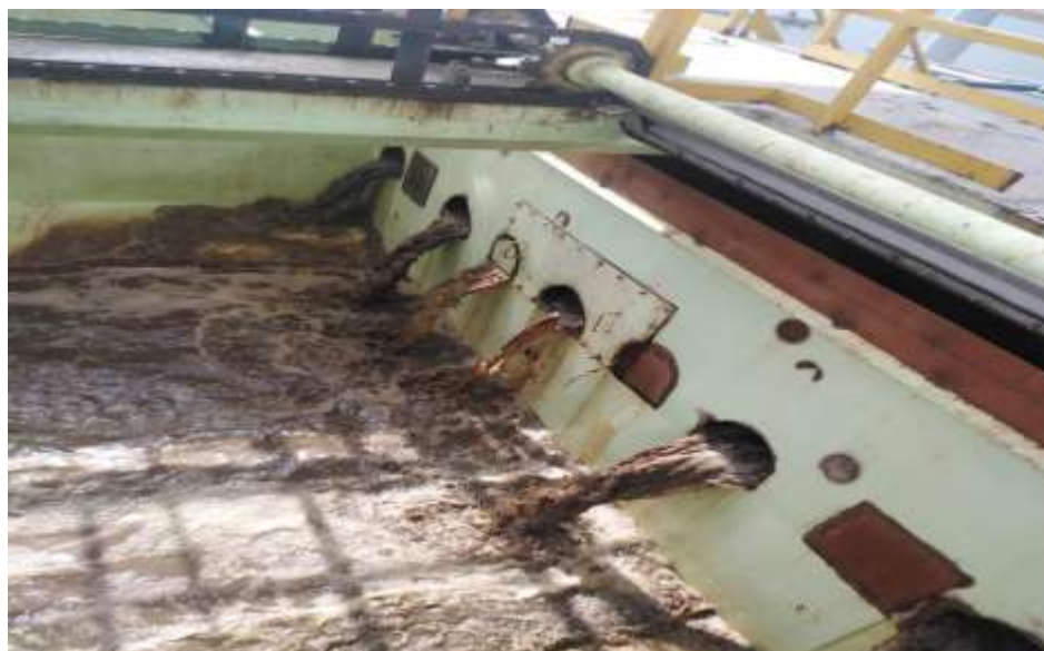
Figura 25: Estructura después de la mejora de la celda DAF.
