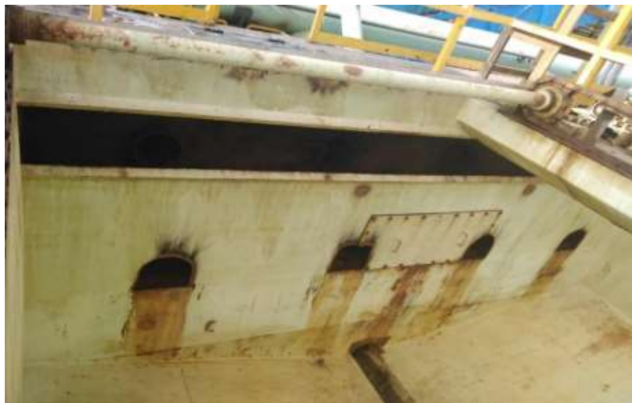
Figura 24: Estructura inicial de la celda de tratamiento físico.
