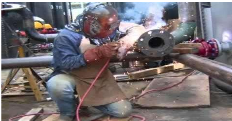
Figura 23: Personal contratado realizando trabajos en la zona.
