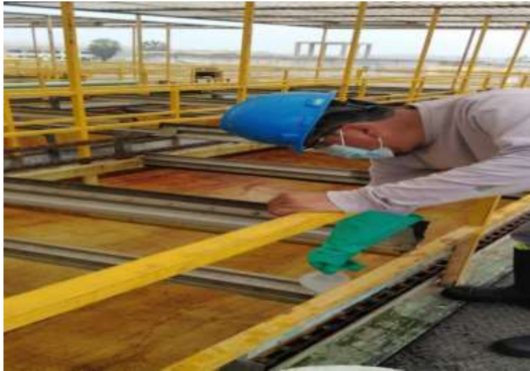
Figura 29: Aplicación de soda cáustica en limpieza.
