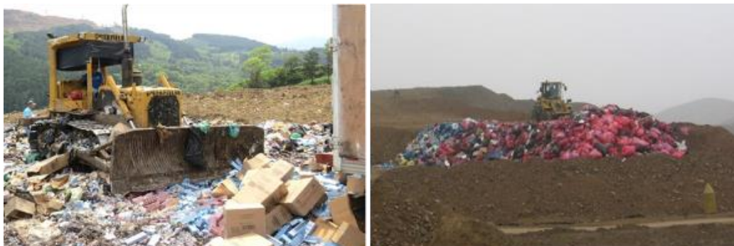
Figura 35: Manipulación y Enterramiento Inadecuadas de Residuos Fuente: Propia KANAY S.A.C.
