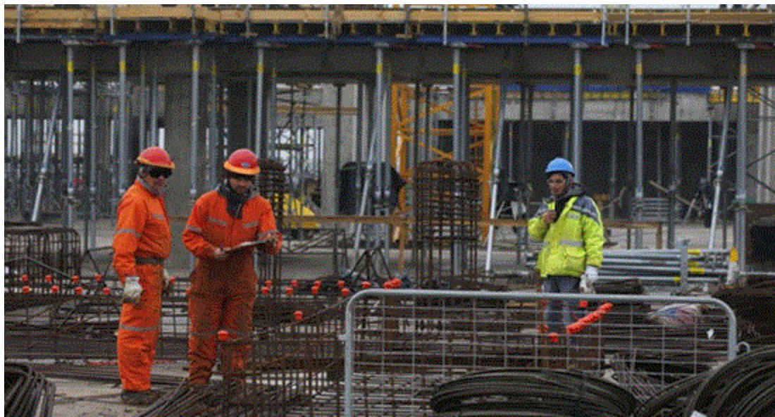
Figura N° 1.2: Giro de la Empresa – Sector Construcción
