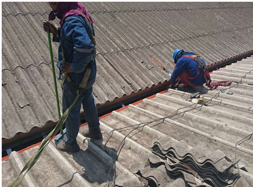
Instalación de canaleta
