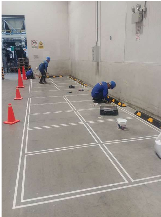
Instalación de topos de jebe
