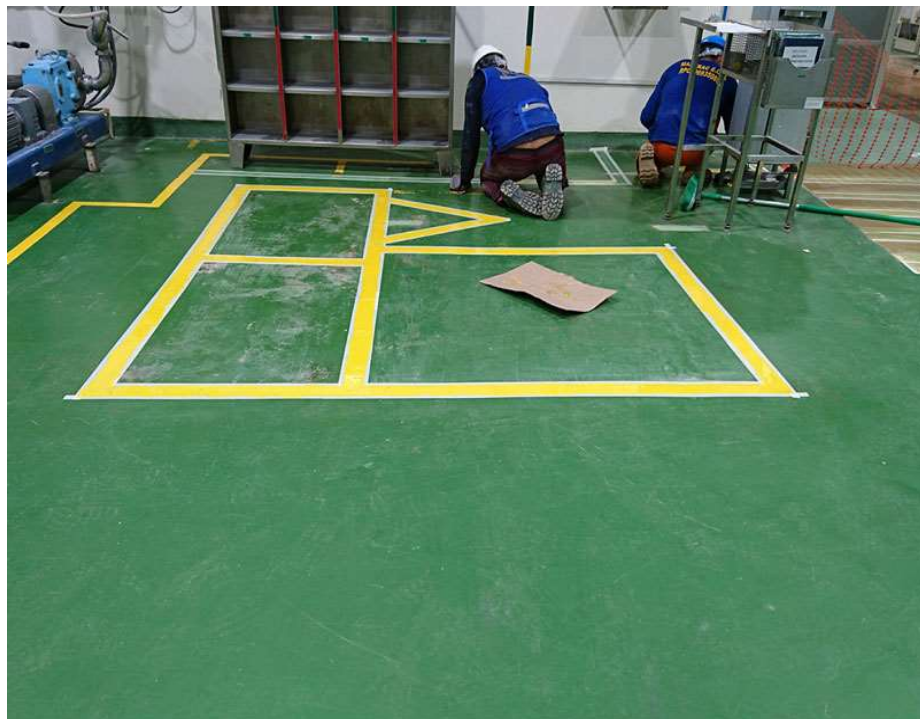
Pintado de señalización
