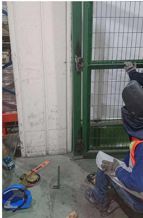
Reparación de puerta
