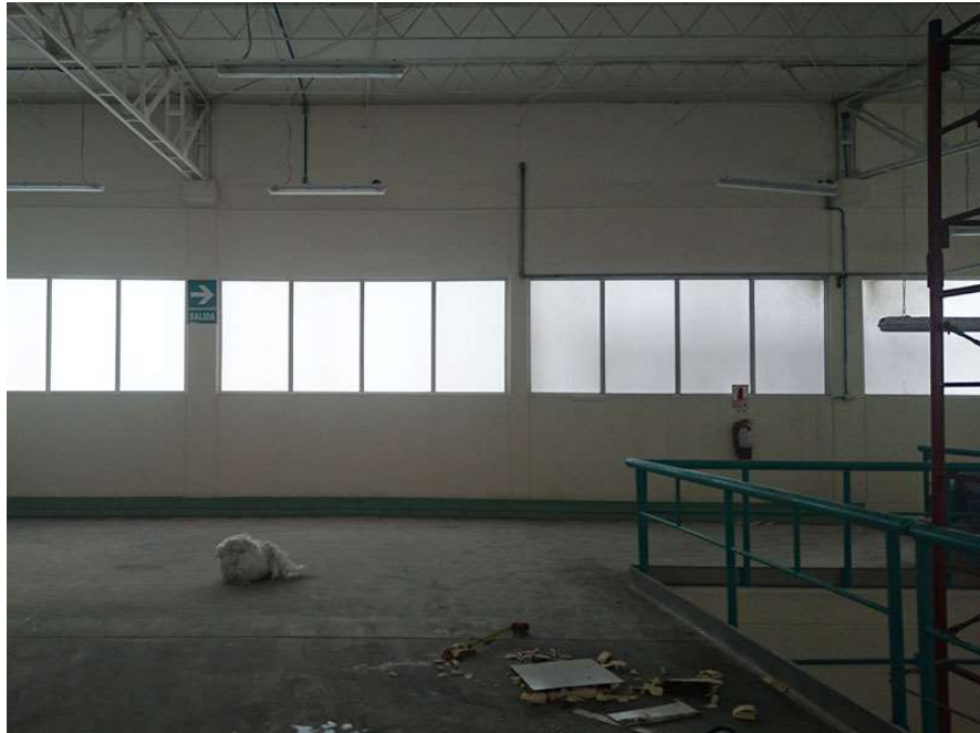
Instalación de ventanas
