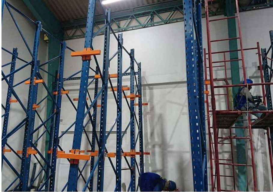
Instalación racks para almacenes
