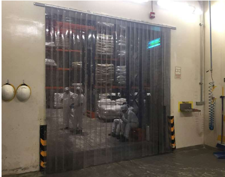
Instalación de cortinas
