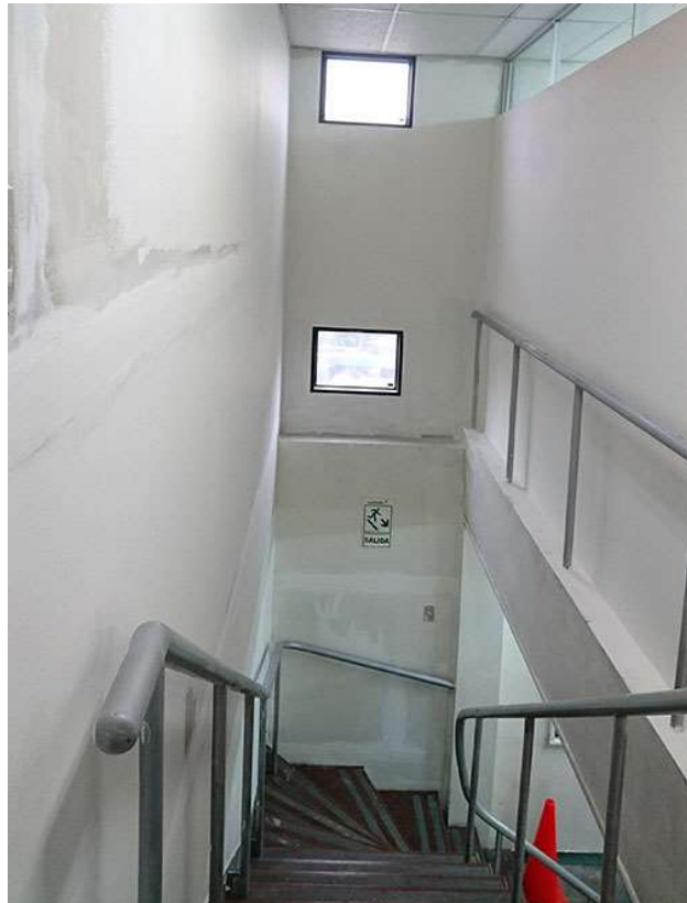
Instalación de drywall
