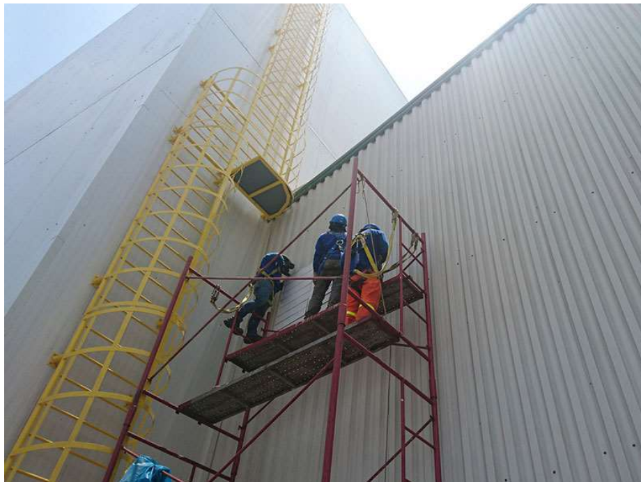
Mantenimiento extractor de aire
