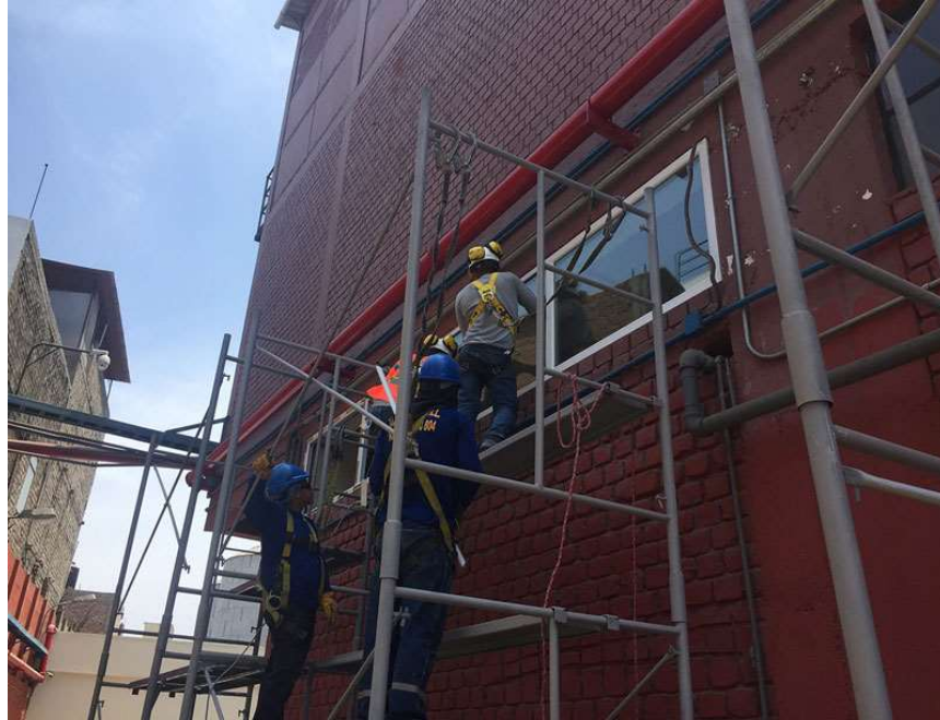
Instalación ventanas acústicas
