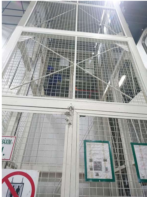
Instalación de malla
