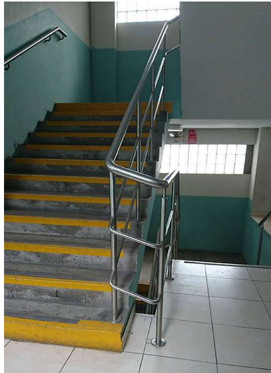
Instalación de baranda
