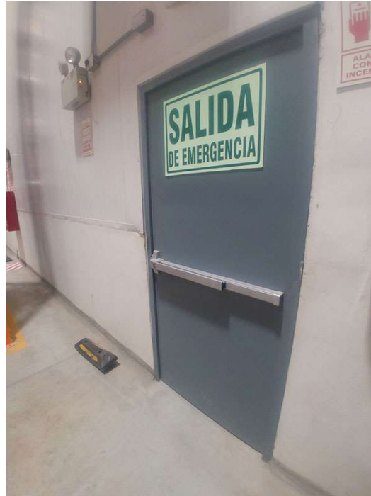
Instalación de puerta
