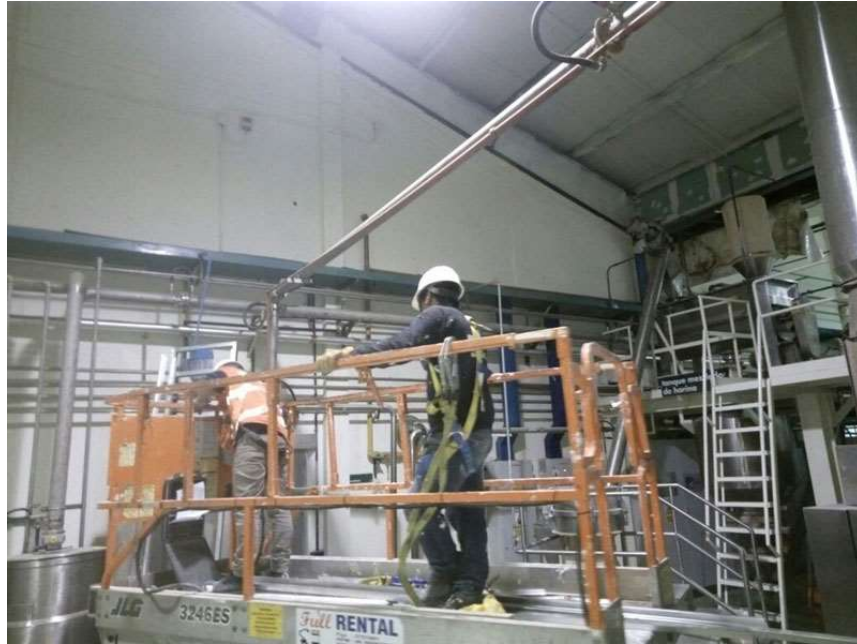
Instalación tubería inox
