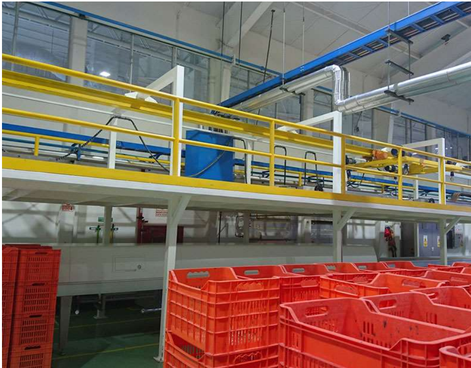
Instalación de escalera
