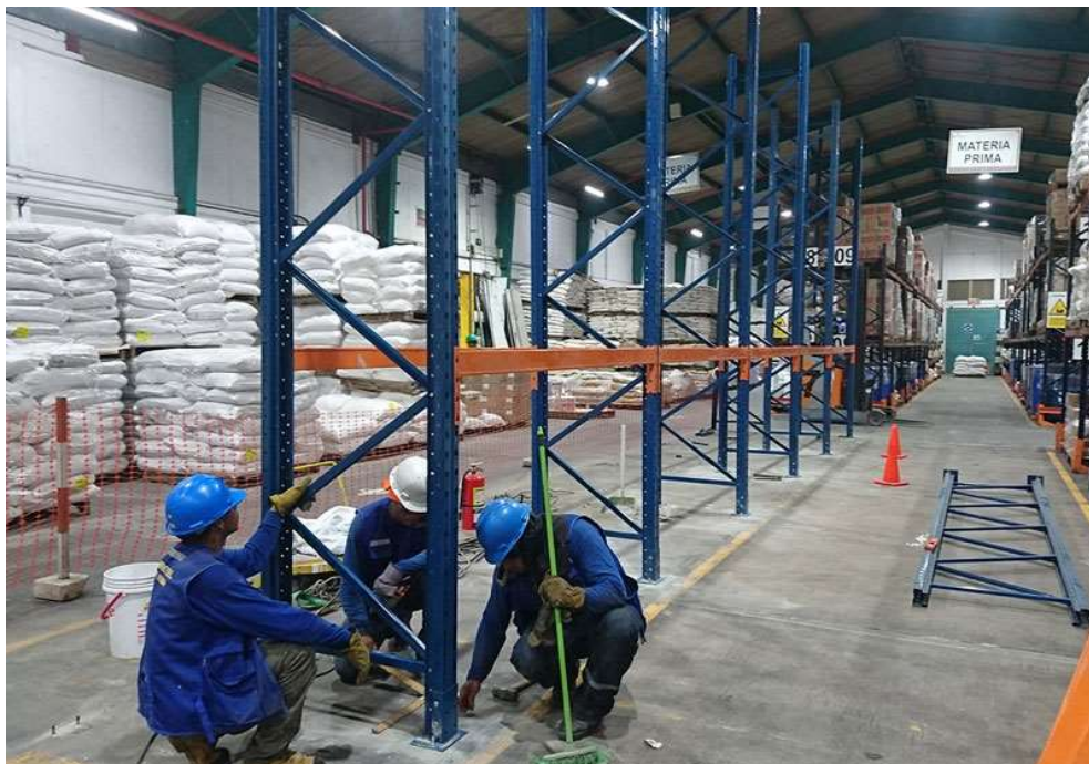
Instalación de rack
