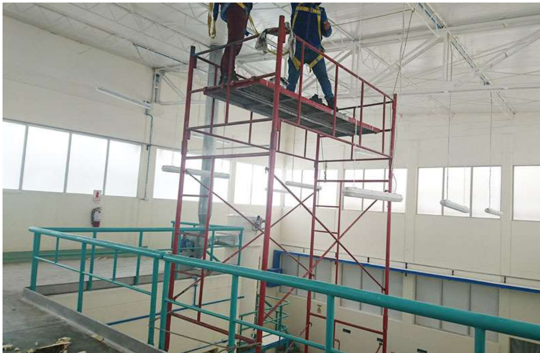
Reparación de techo
