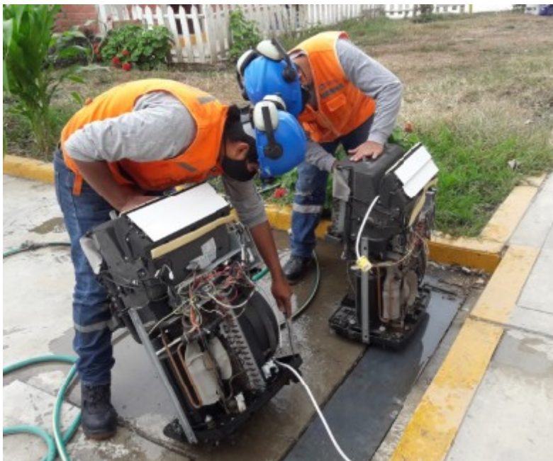
Figura 16: Mantenimiento del equipo Aire acondicionado portátil
