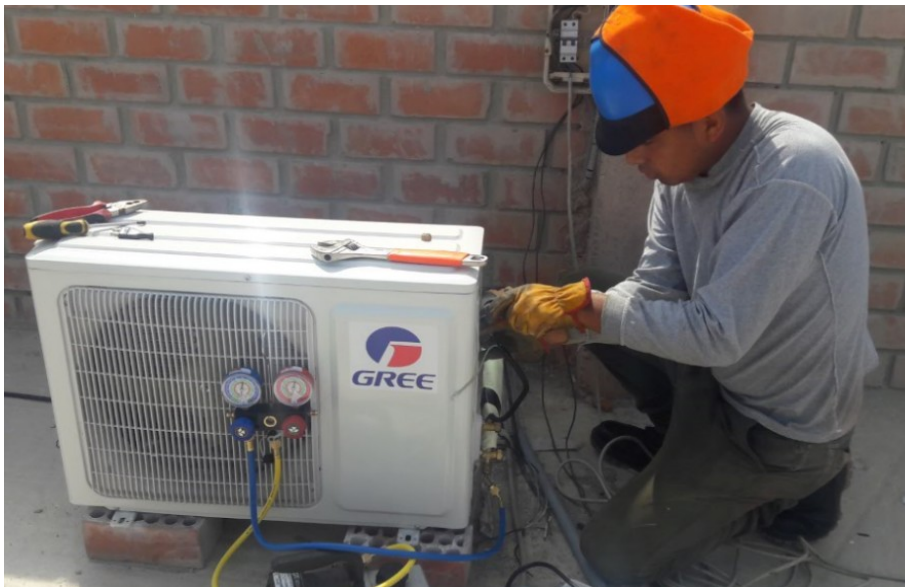
Figura 7: Servicio de Mantenimiento de Aire Acondicionado.
