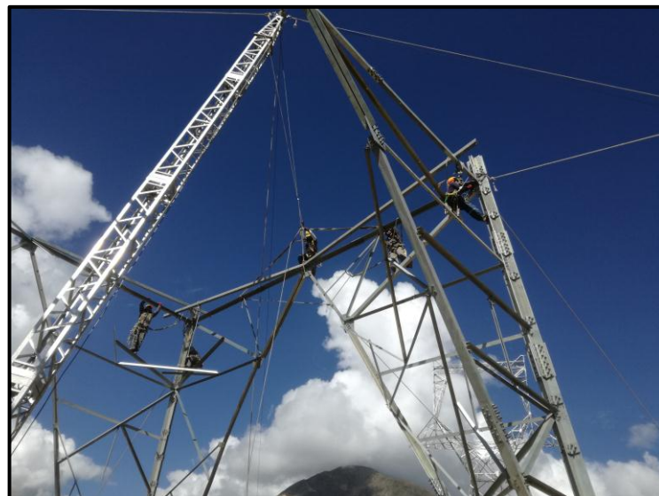
Figura 14. Ensamble de estructura en altura. Fuente: Fotografía tomada en la etapa de montaje de torre.
