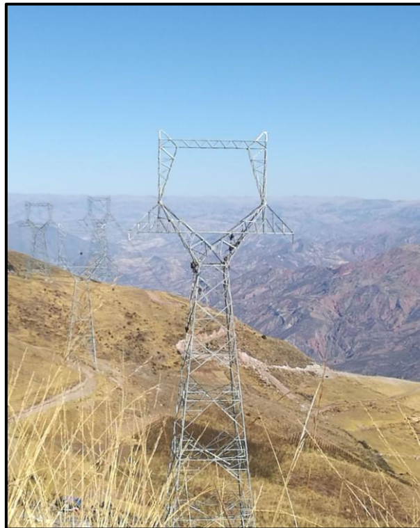
Figura 16. Revisión y adecuación de torre. Fuente: Fotografía tomada en la etapa de Revisión de torre.
