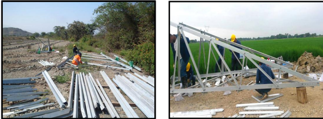
Figura 7. Ensamble de segmentos componentes. Fuente: Fotografía tomada en la etapa de Prearmado.
