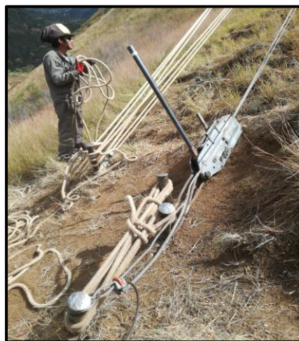
Figura 9. Instalación de vientos.
