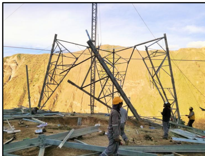
Figura 13. Montaje de estructuras. Fuente: Fotografía tomada en la etapa de montaje de torre.
