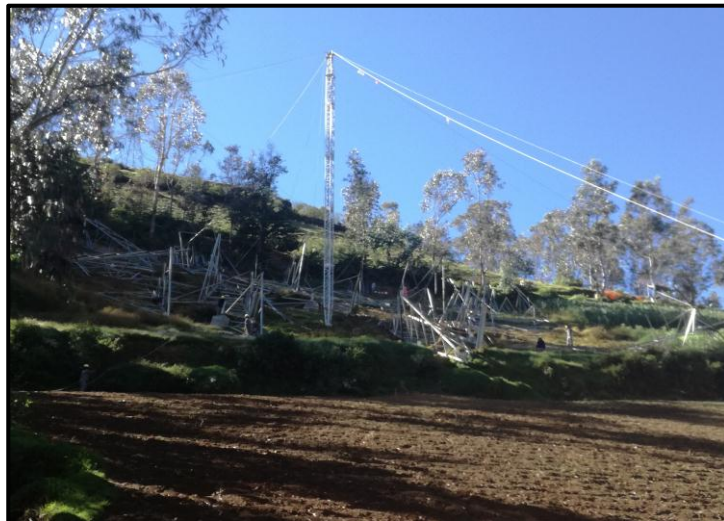
Figura 12. Instalación vertical pluma de izaje. Fuente: Fotografía tomada en la etapa de montaje de torre.
