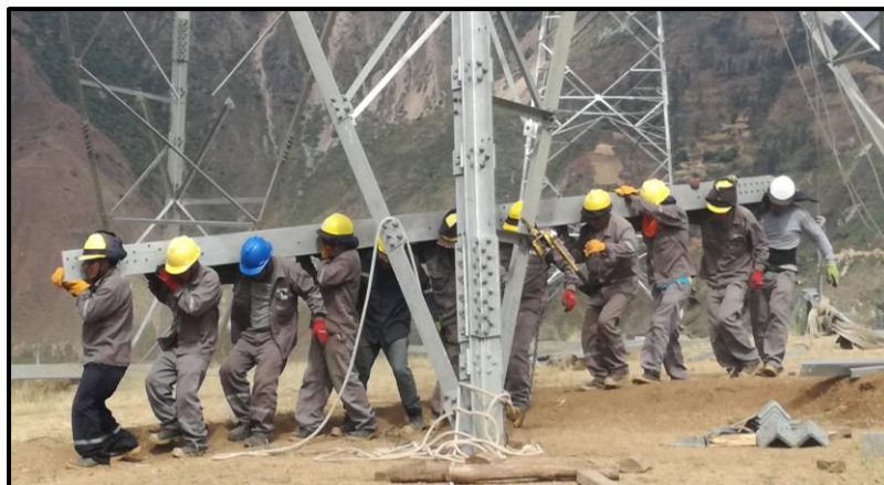
Figura 17. Carga manual de estructura.
