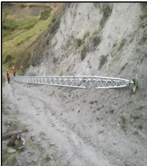
Figura 10. Ubicación central pluma de izaje.
