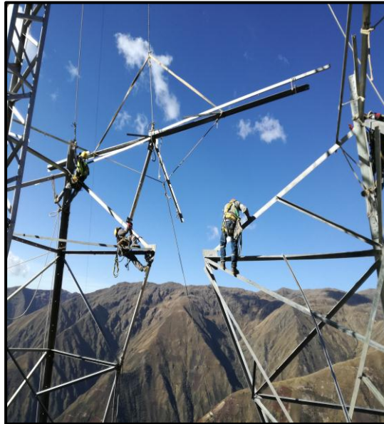
Figura 18. Trabajo de izaje de estructura. Fuente: Fotografía tomada en la etapa de montaje.
