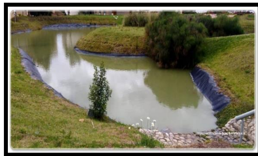
Figura 5. Trabajos de Impermeabilización
