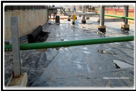
Figura 9. Trabajos para manejo de aguas.
