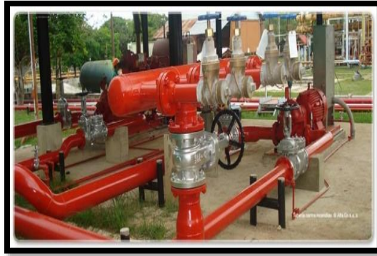
Figura 10. Trabajos de tuberías.
