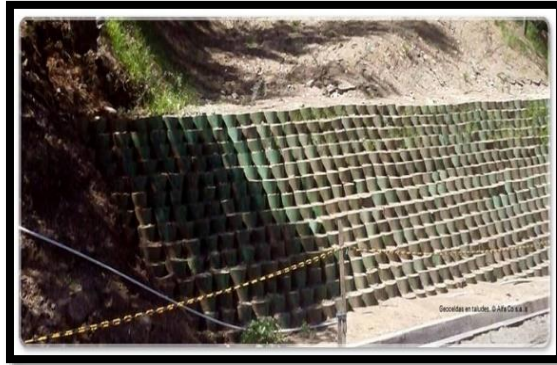
Figura 8. Trabajos de Geoestructuras.
