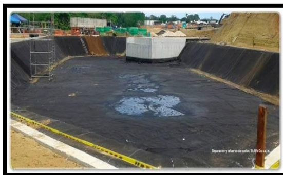
Figura 7. Trabajos para separación y refuerzos de suelos.
