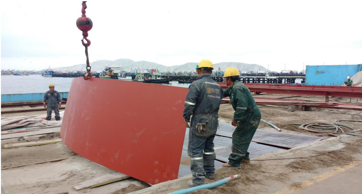
Foto N°5: Maniobra con Grúa Volteo de planchas en Carpa
