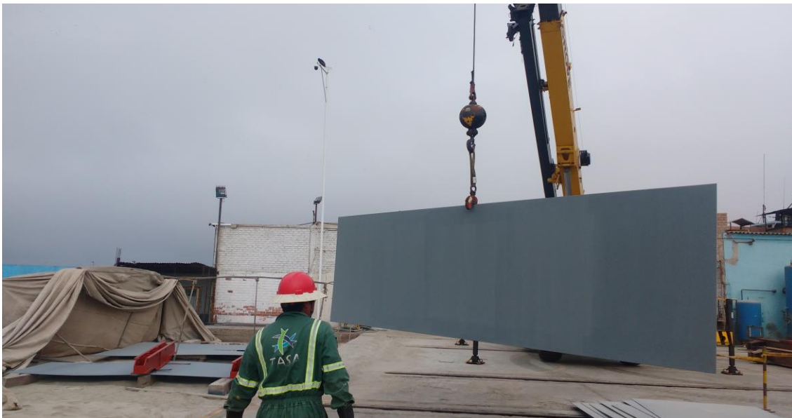
Foto N°2: Maniobra con Grúa de ubicación de planchas en Carpa.
