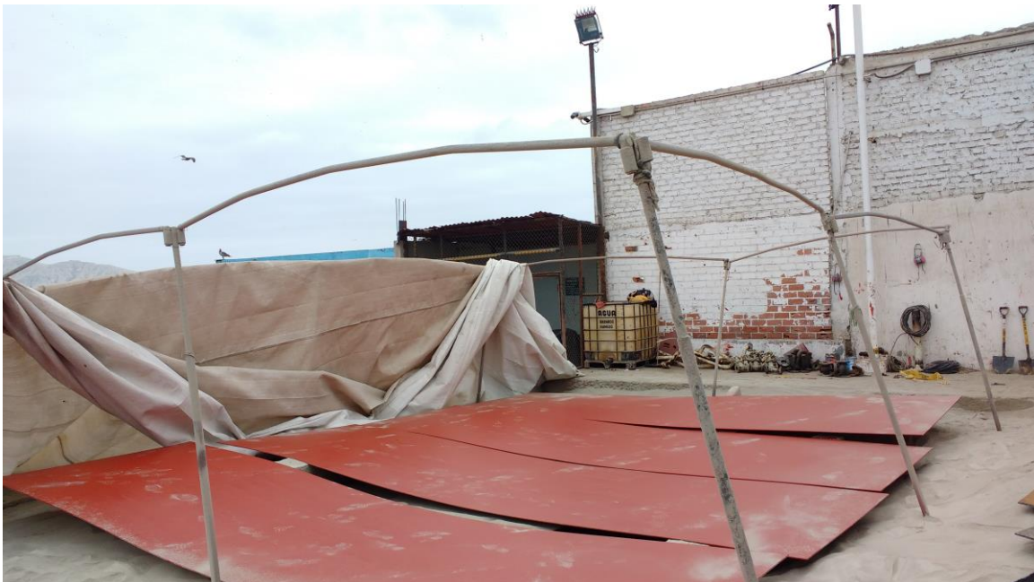
Foto N°4: Planchas arenadas primera Cara
