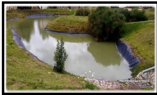
Figura 5. Trabajos de Impermeabilización Fuente: Sitio Web de la empresa.
