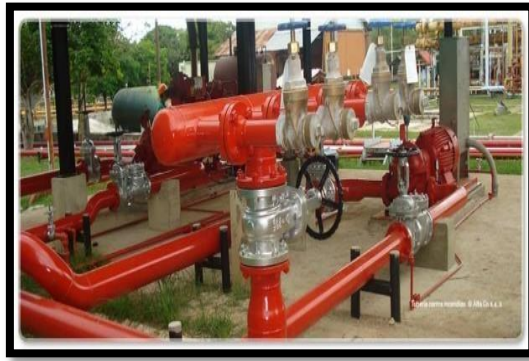
Figura 10. Trabajos de tuberías.
