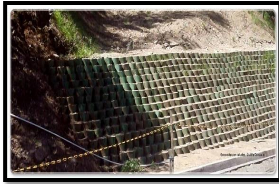
Figura 8. Trabajos de Geoestructuras.
