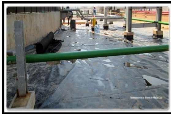
Figura 9. Trabajos para manejo de aguas.
