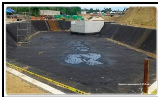
Figura 7. Trabajos para separación y refuerzos de suelos.
