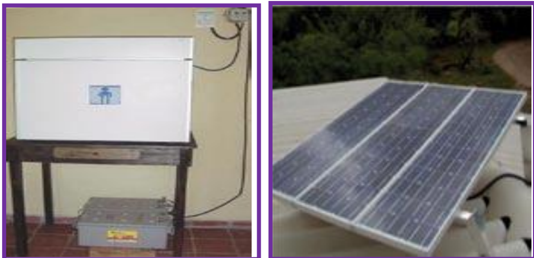
Fig. 4: Refrigerador fotovoltaico (energía solar)
