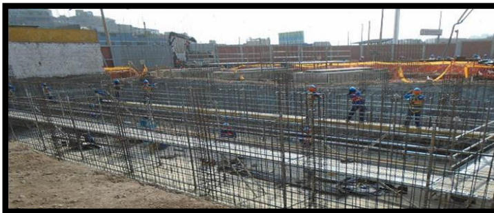
Figura 5. Obra San Luis
