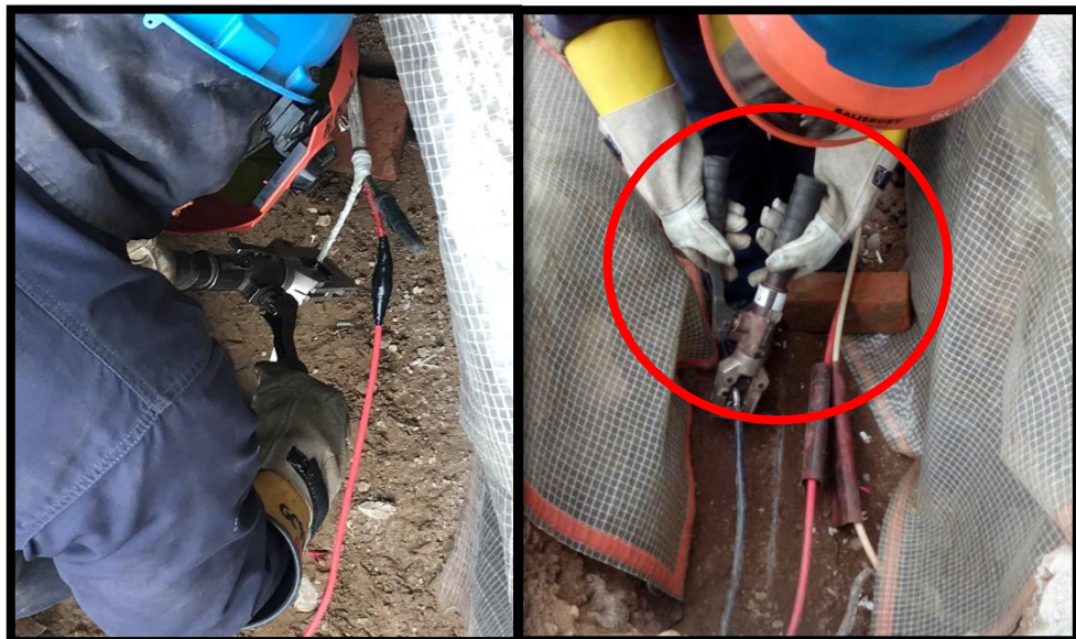
Figura 38. Implementación de Separador de Fases Fuente: Fotografía Propia.
