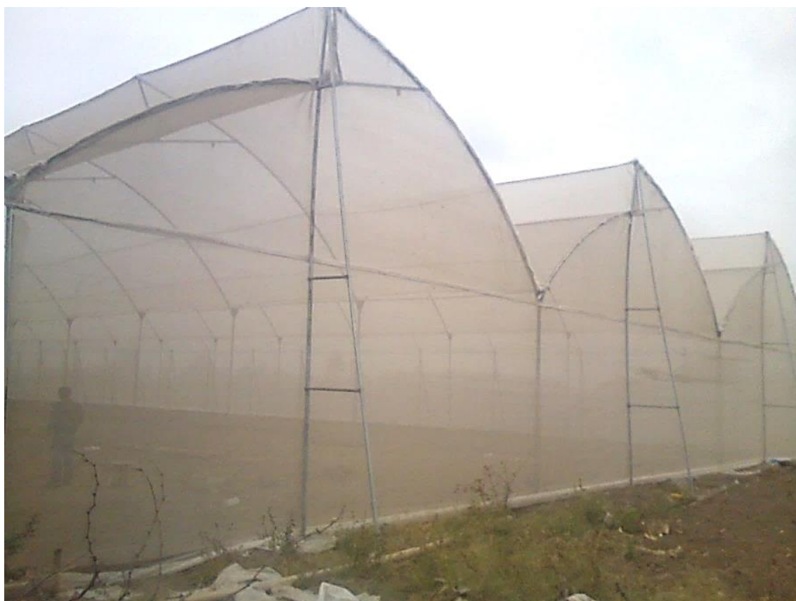
Posterior del ambiente controlado en construcción
