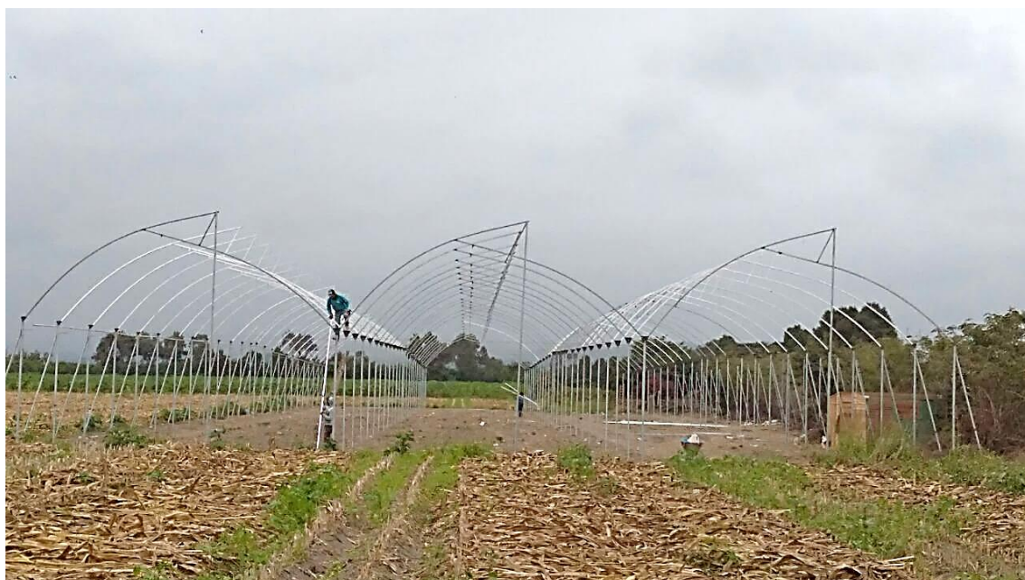
Visita en campo en la ejecución de módulos de ambiente controlado
