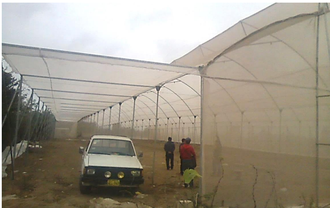
Parte lateral (ampliación) del ambiente controlado en construcción
