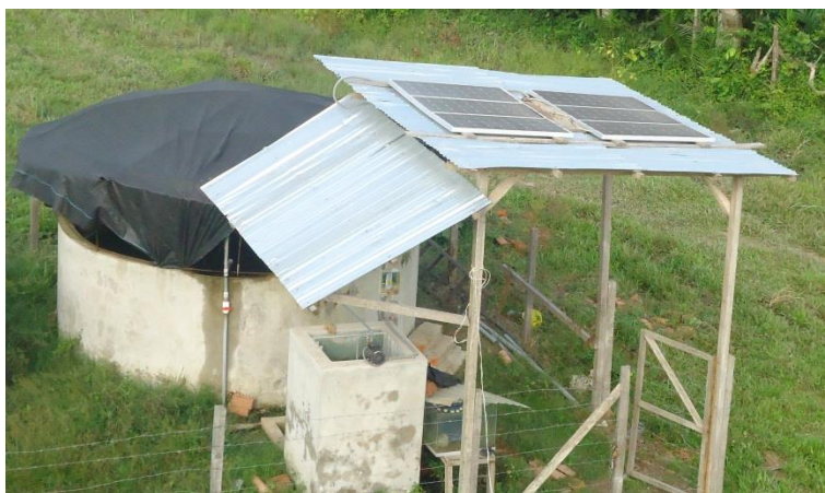
Fuente: fotografía propia, tanque de cemento
