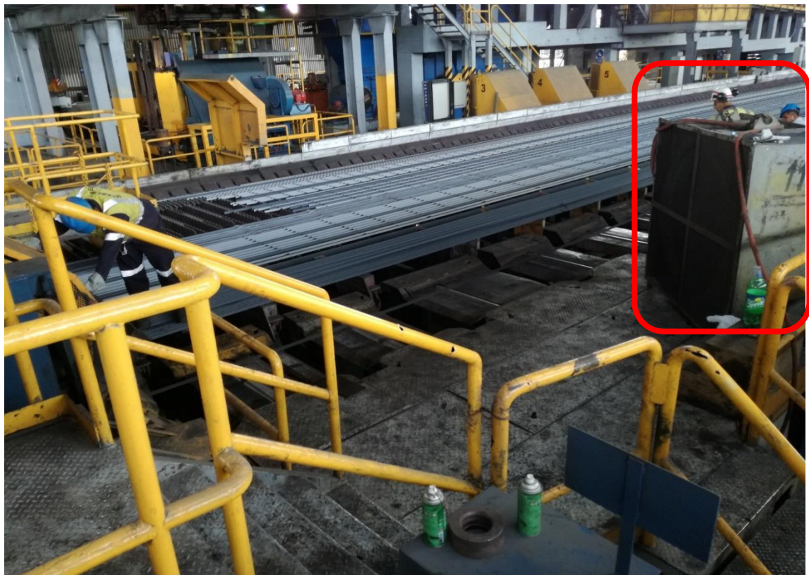
Figura 18 Colocación de ventilador externo
