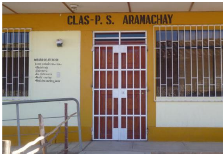
Figura 8 Puesto de salud Aramachay
