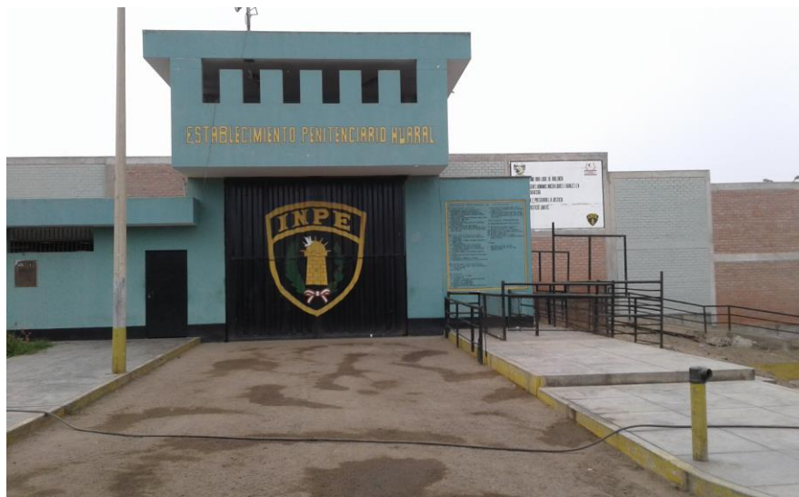
Foto N° 1. Frontis del Establecimiento Penitenciario.
