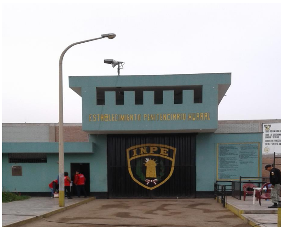
Foto N° 2. Frontis del Establecimiento Penitenciario.
