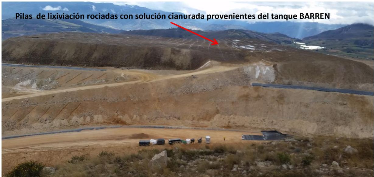
GRAFICA N° 3: Vista de parte superior de pilas de lixiviación, rociadas con solución cianurada desde el tanque Barren.
