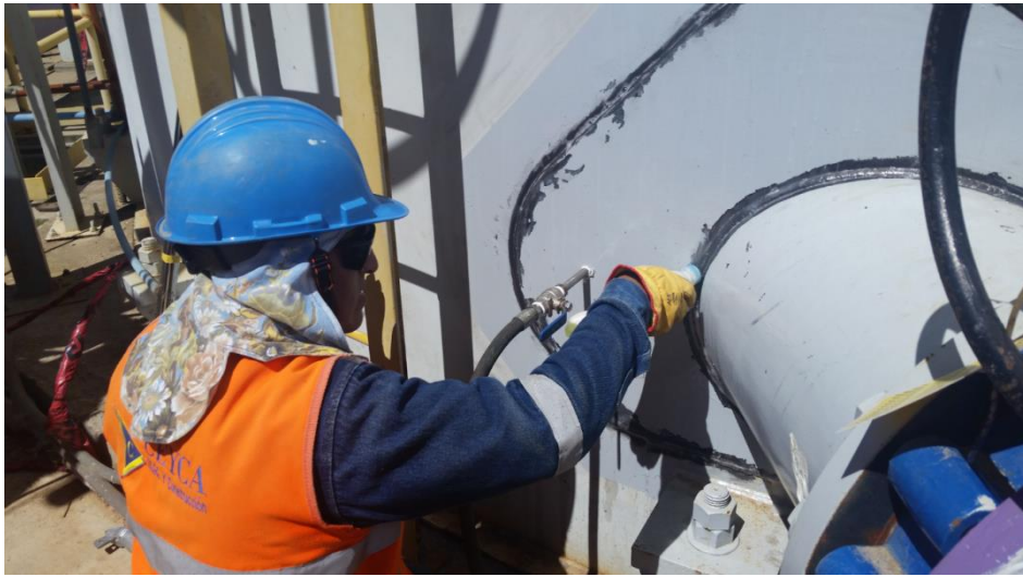
GRAFICA 8: Prueba neumática: Se requiere equipo de prueba neumática y personal calificado.
