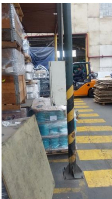
Señalización descuidada con pintura amarillo trafico
