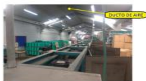
La BOBINADORA no cuenta con cubierta superior.
