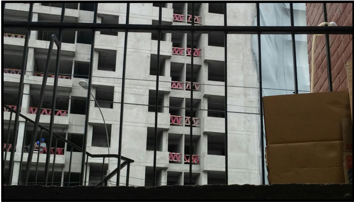
Gráfico Nº 7. Obra de construcción particular, ubicada en Av. Huiracocha Cdra 01.
