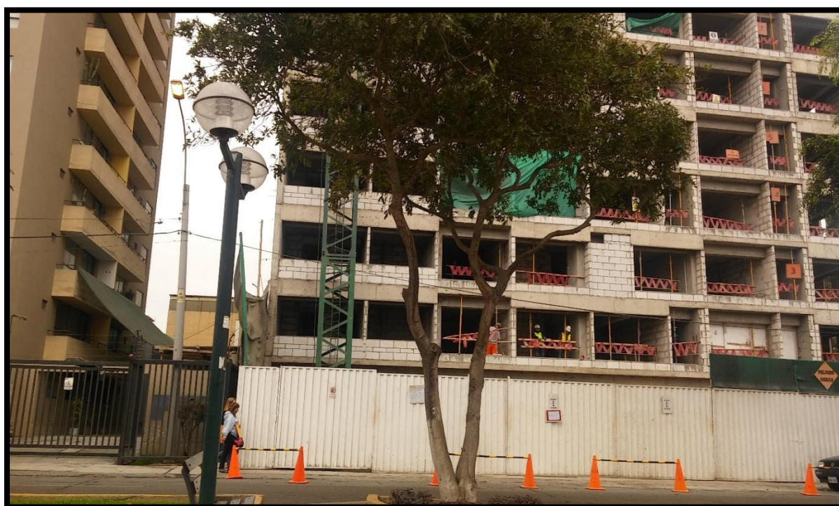
Gráfico Nº 14. Obra de construcción particular, ubicada en Av. San Felipe Cdra
