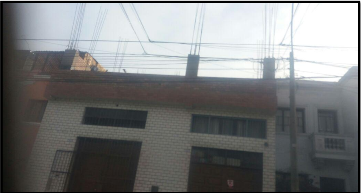
Gráfico N° 20. Obra de construcción particular, ubicada en Jr. Caracas cdra 02
