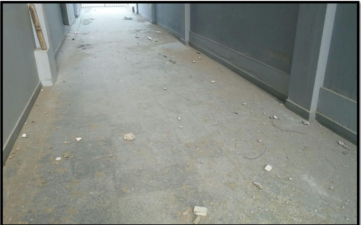
Gráfico Nº 10. Obra de construcción particular, ubicada en Av. Estados Unidos y Av. San Felipe.
