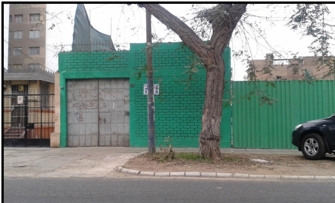
Gráfico Nº 3. Obra de construcción particular, ubicada en Av. Mariátegui y Pachacutec
