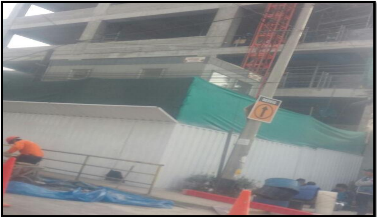
Gráfico N° 22. Obra de construcción particular, ubicada en Jr. Estados Unidos cdra. 03
