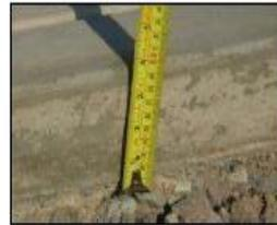
En la imagen de lado izquierdo, se verifica la construcción del sardinel en el borde de la pista con una altura de 20cm (deben ser 30cm). Y en la imagen de lado derecho, se verifica que no se está considerando sardinel en el lado de las viviendas, solo 10cm que corresponde al espesor de la vereda
